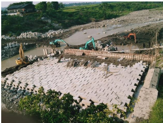
(a) Pengendali dasar sungai dengan teknologi modular
